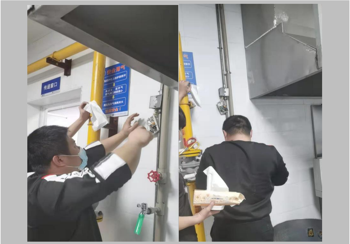
检查维修自营食堂燃气报警器
