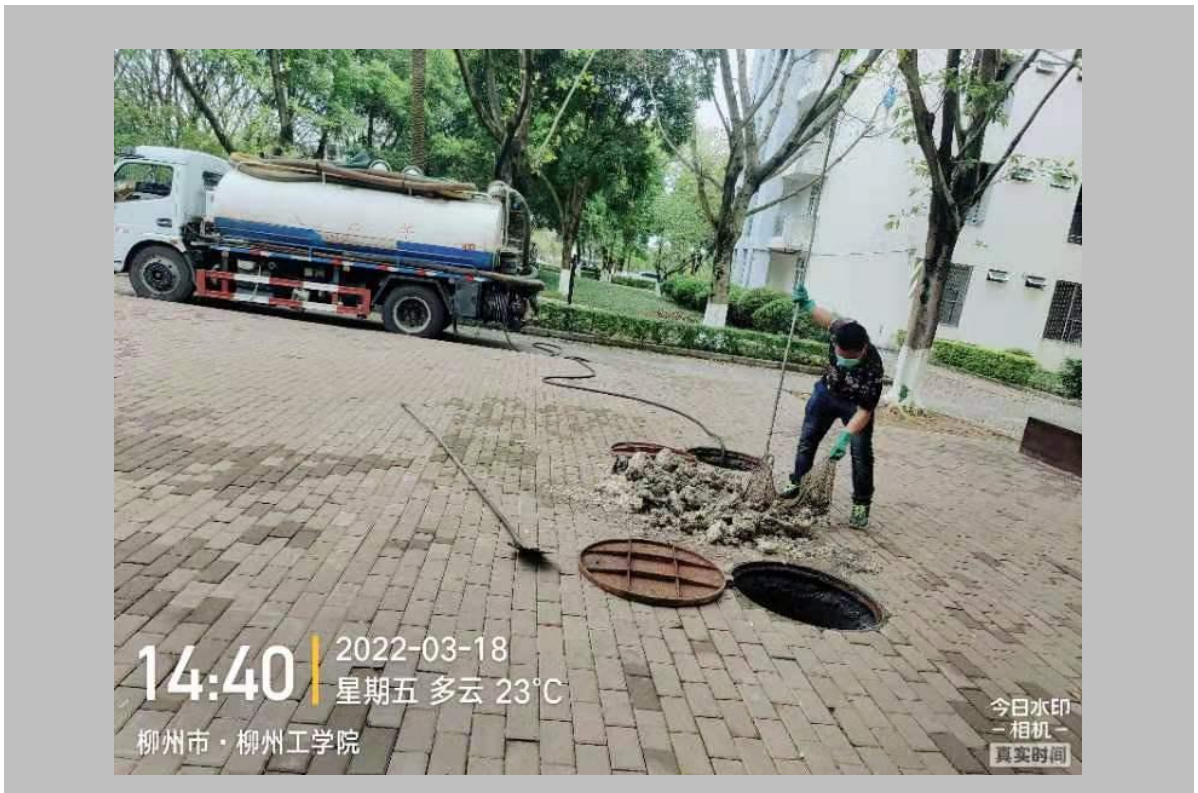
疏通清理南校区食堂周边堵塞的排污管道
