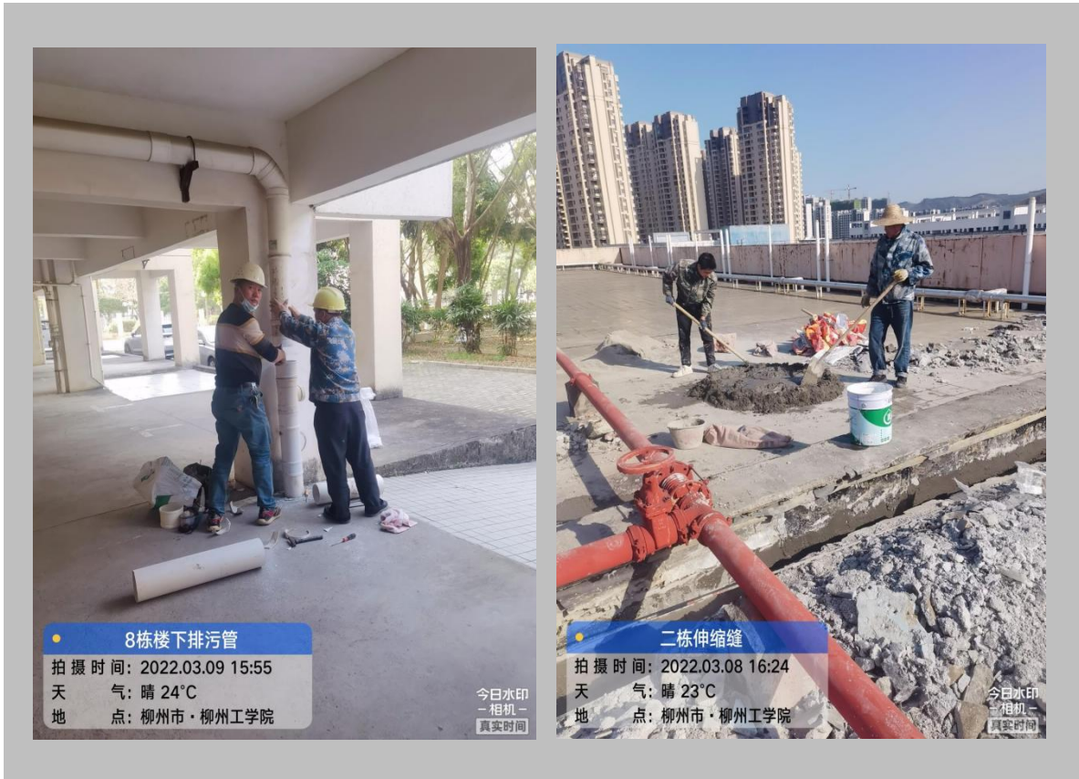
维修8栋宿舍楼断裂排污管、2栋宿舍楼屋面伸缩缝
