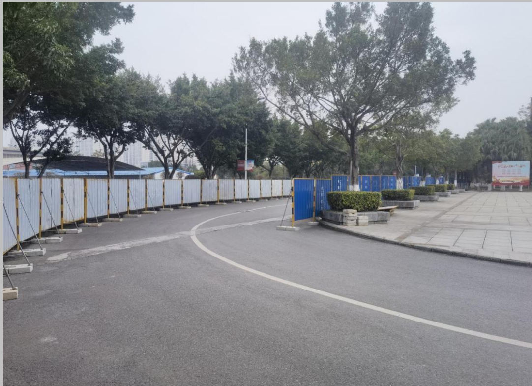
基本完成新建排污管工程的施工围挡搭设工作
