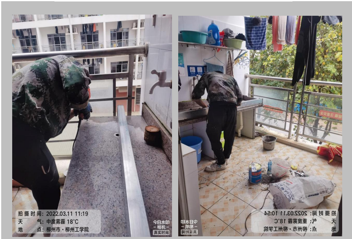
维修宿舍楼洗漱台
