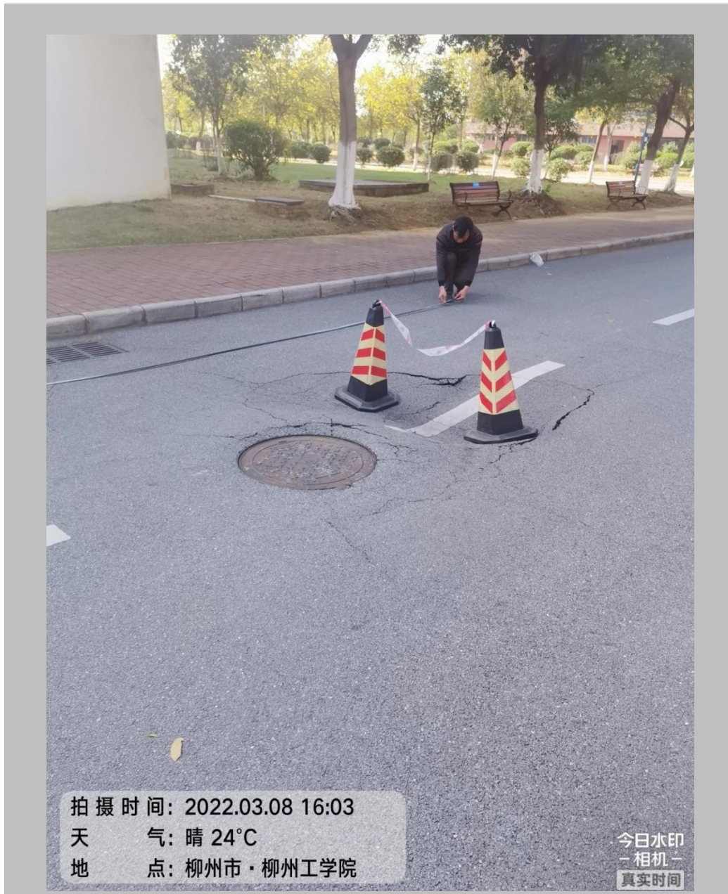
现场勘查二教旁道路塌陷问题，制定维修方案
